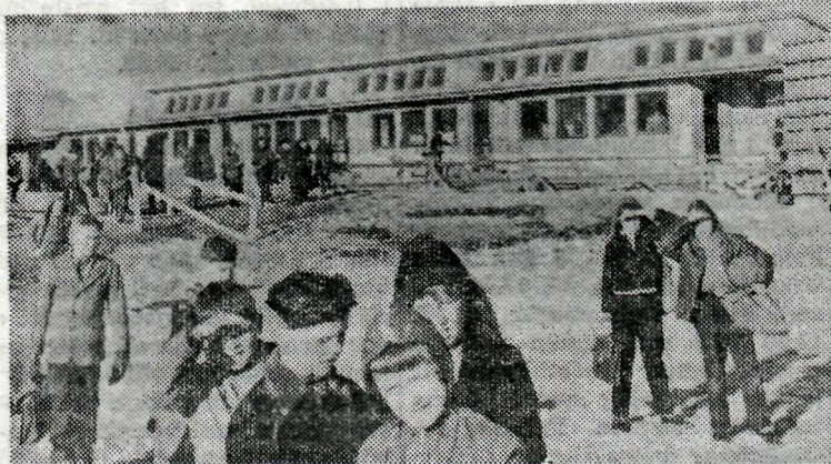
Breiðagerðisskólinn. Álman, sem nú þegar er byggð og sýnd er á uppdrætti. Til hægri sést á miðálmuna, sem er í byggingu.
