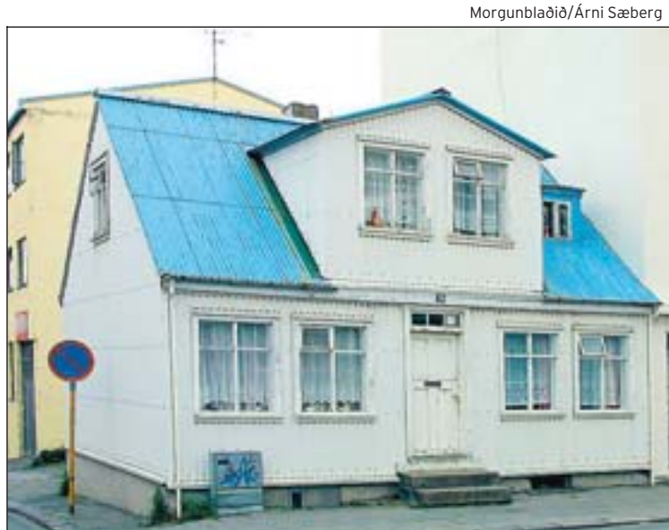
Vesturgata 28. Húsið var upphaflega byggt 1881. Í fyrstu brunavirðingu frá 25. október sama ár segir, að húsið sé byggt af bindingi múruðum með múrsteinum og með járnþaki á plægðum borðum.
